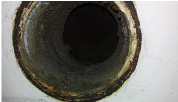
Intérieur du conduit
